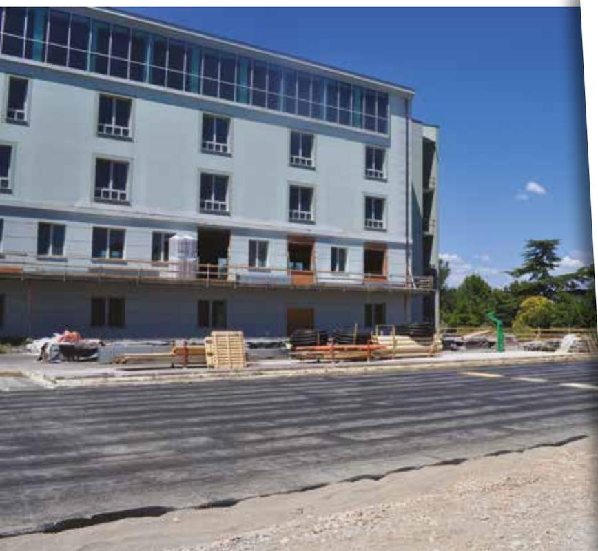
*Nella foto il completamento della realizzazione della soletta in cemento armato a copertura dei locali interrati.*
