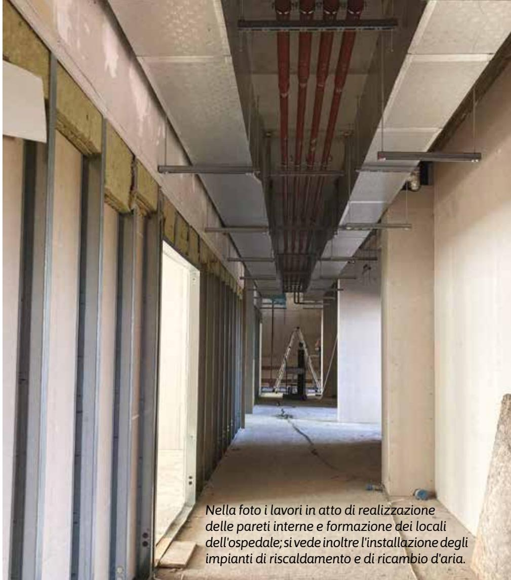
*Nella foto i lavori in atto di realizzazione delle pareti interne e formazione dei locali dell'ospedale; si vede inoltre l'installazione degli impianti di riscaldamento e di ricambio d'aria.*
